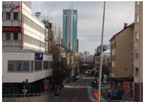
Stora Gatan. Byggt och formad under rivningsraseriets tid.
