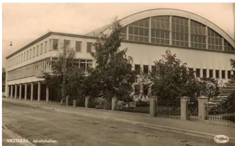
Idrottshallen invigdes 1940 med uppvisning av Sofia-flickorna inför fullsatta läktare. Den revs 1992.
